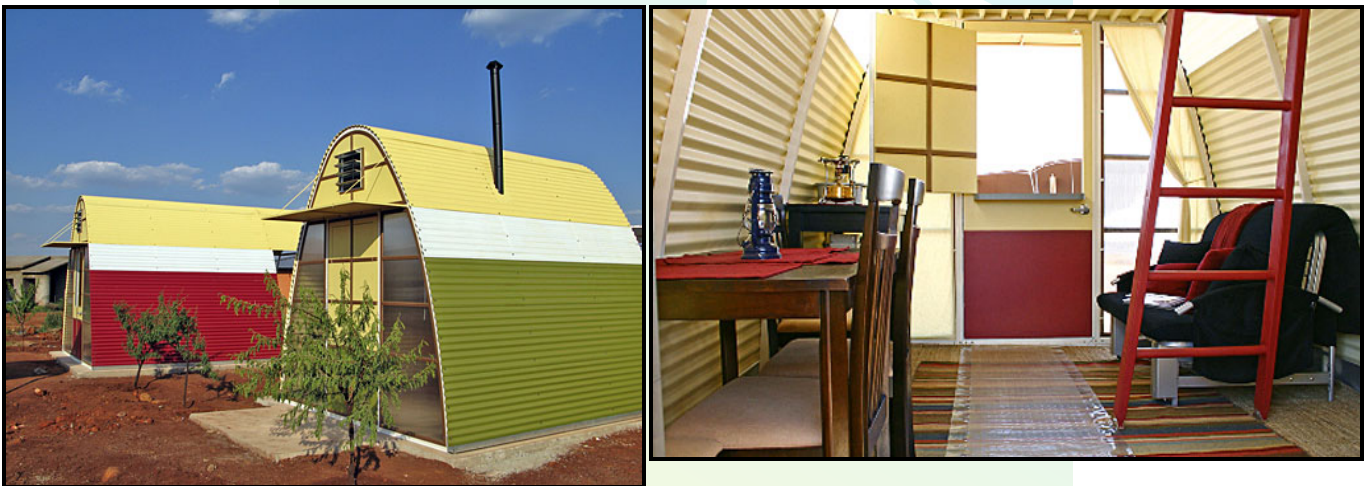
FIGUUR 8b: BSB Design, Architecture for A Change, (AFAC) (Argitektuur vir 'n Verandering) . Prototipe vir die gebruik van bekostigbare/mikro-behuising in Suid-Afrika, sonpanele, sinkplaat, glas, 2013. (Buite- en binne-aansigte)
